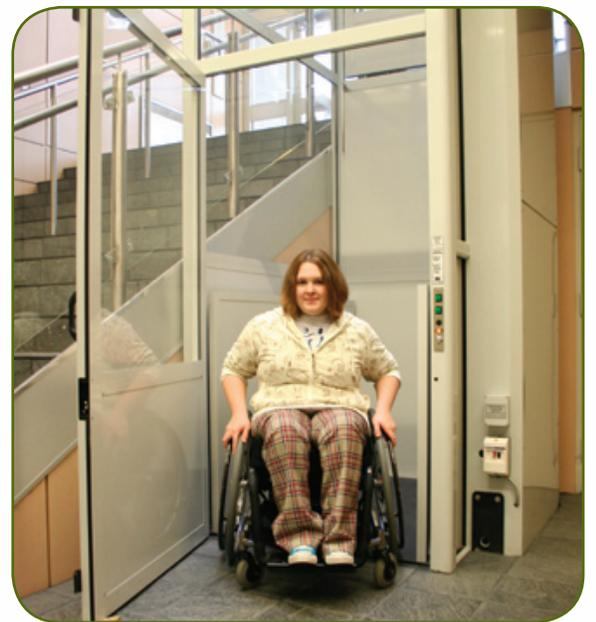
El modelo Garaventa Genesis es una plataforma vertical concebida para proporcionar acceso dentro de un edificio público. La máquina viaja dentro una estructura completa, auto portante, como es mostrado, o puede ser colocado en un hueco construido por otros. Nuestro diseño único en aluminio anodizado es durable, robusto y atractivo.
